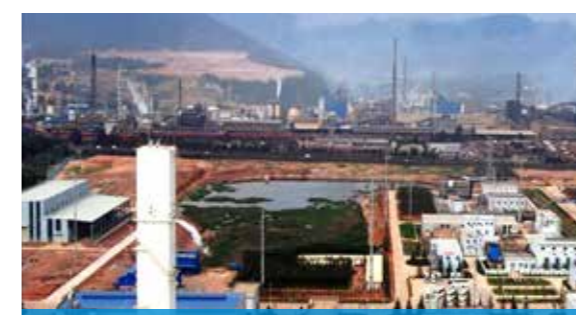
昆钢海绵工业园区项目
