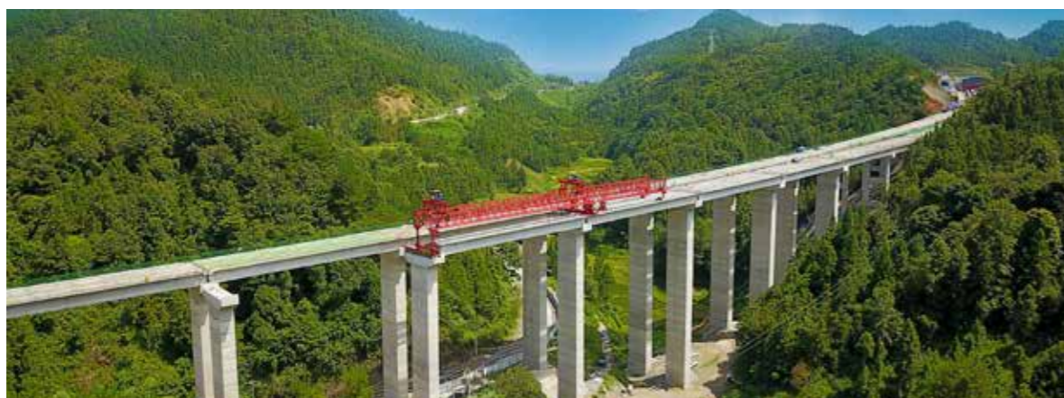
贵州三荔高速公路项目水龙大桥
