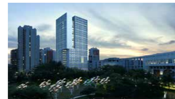
清华大学深圳研究生院创新基地建设工程（二期）
