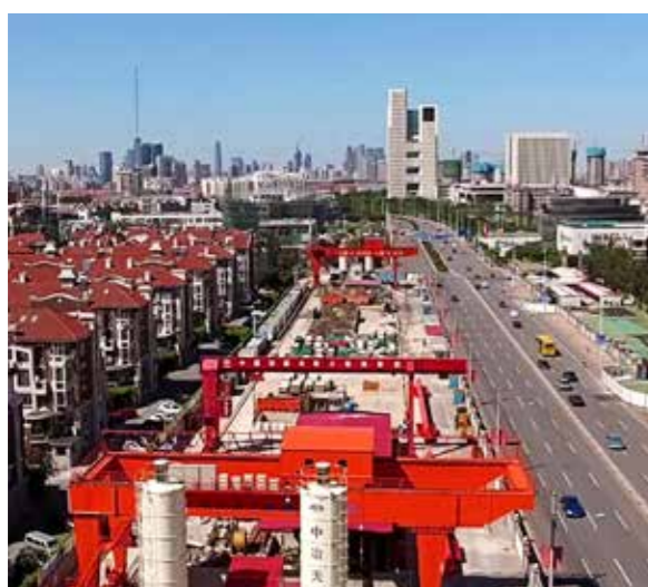
天津地铁 6 号线 R3 标项目
