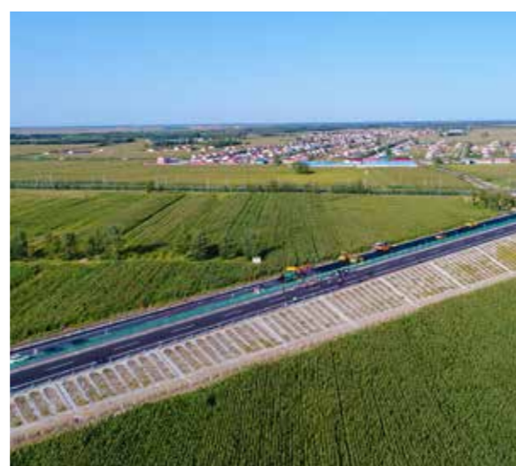
内蒙古通辽至鲁北高速公路
