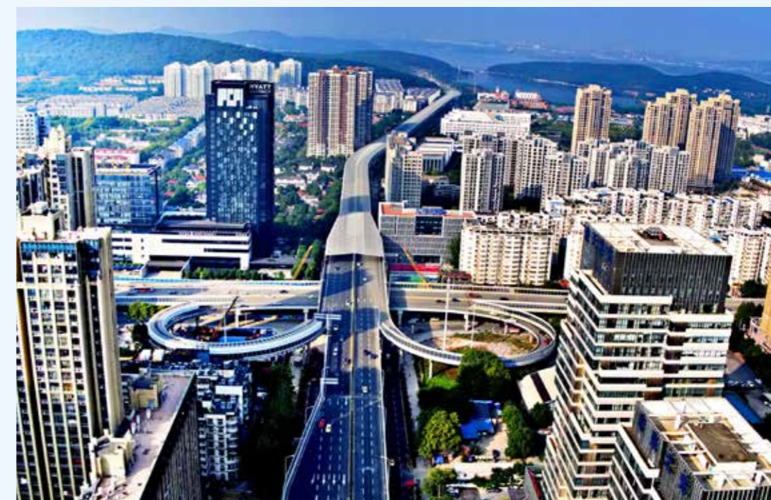
中国光谷科技会展中心大道快速化改造项目
